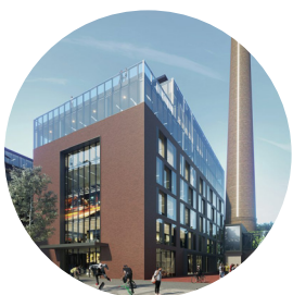
UNIT City Campus B11, B14, B15, м. Київ, вул. Сім'ї Хохлових
