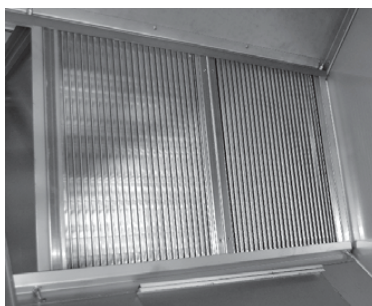
Пластинчатый рекуператор (рис. 12)
