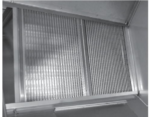
Пластинчастий рекуператор (рис. 25)
